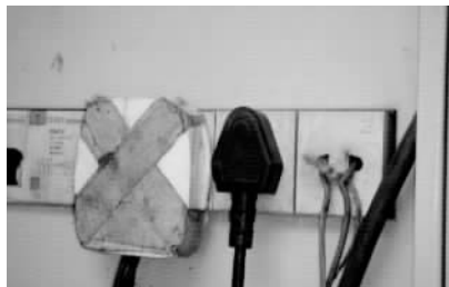
图 2-3 不规范的使用电线实例
